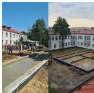
Rozbudowa szpitala w Sierpcu.
